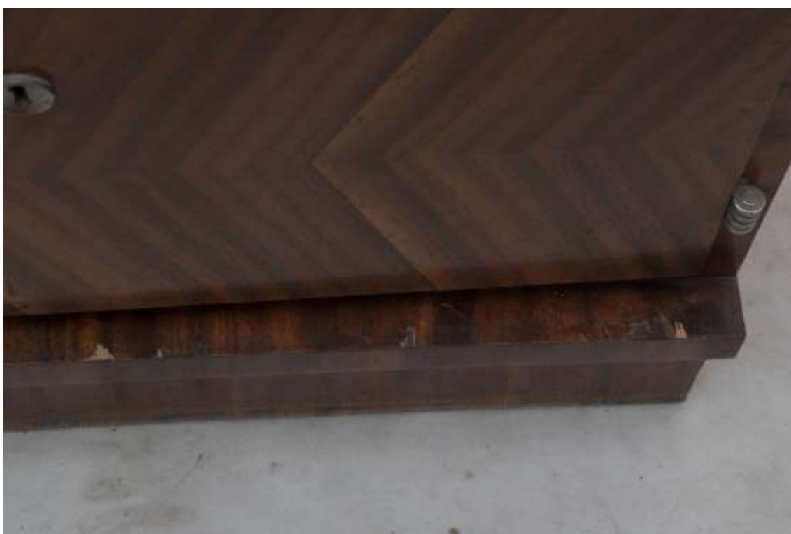
Detail poškození soklu, odštípnutá dýha
