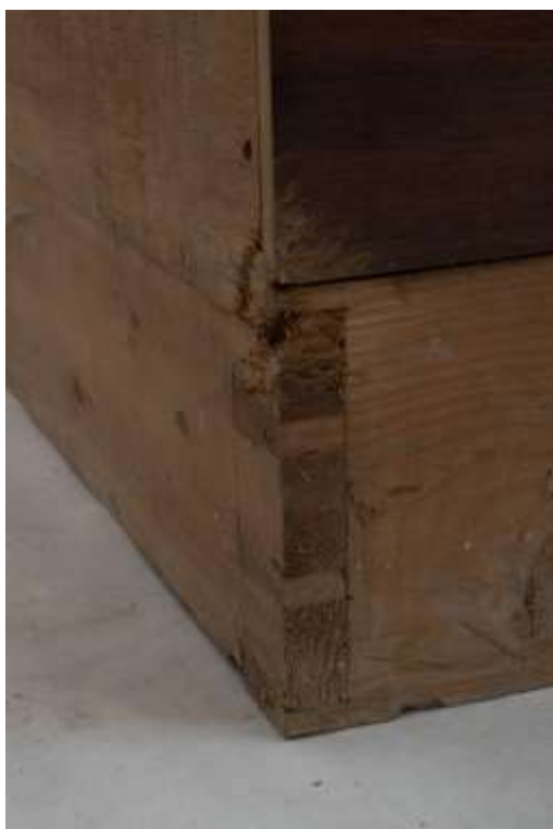
Detail poškození rohu
