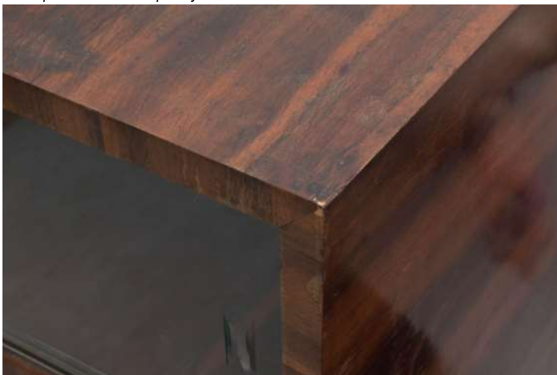
Detail rohu a odštíplé dýhy
